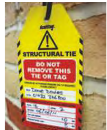
Legende: Dieser Gerüsthalter darf nicht entfernt werden
